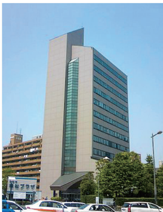
福祉プラザの外観
