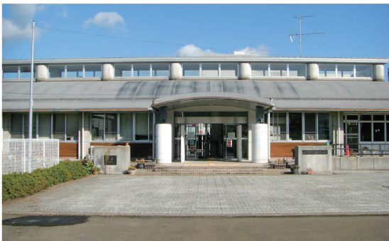
宮城社会福祉センターの外観
